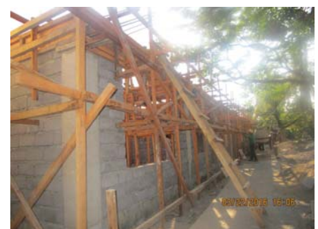
Bauarbeiten für das Schulprojekt „Tagdon Elementary School“ auf den Philippinen
